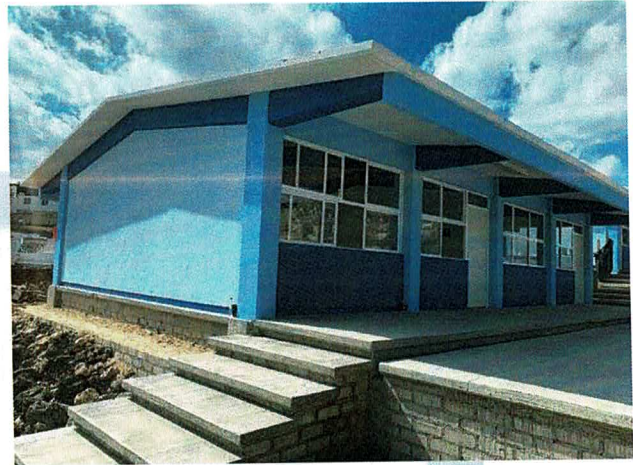
Construcción de un aula de 2 e.e. en estructura u1c y obra exterior en el colegio de bachilleres, en la localidad de la Piedad, municipio de La Piedad, Michoacán.
