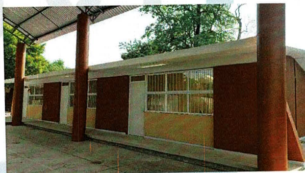
Construcción de tres aulas en la escuela Rafael Ramírez, ubicado en la localidad de Huetamo de Núñez, municipio de Huetamo, Michoacán.
