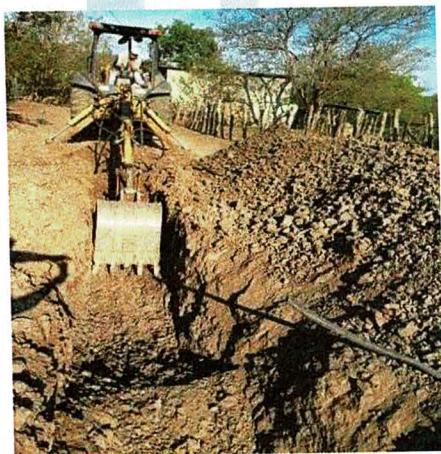
Drenaje sanitario con una longitud de 450 ML, ubicado en la localidad de Paso de Núñez, municipio de Carácuaro, Michoacán.
