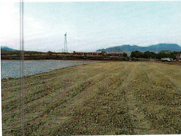
Construcción de primera, segunda y tercera etapa de la cancha de futbol soccer en el instituto tecnológico superior de Huetamo, en la localidad de Huetamo, municipio de Huetamo, Michoacán.
