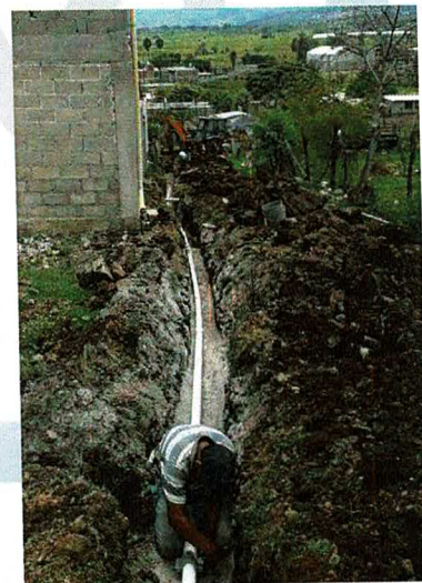
Construcción del Sistema de Agua Potable, en la localidad de Santa Ana, municipio de Juárez, Michoacán.
