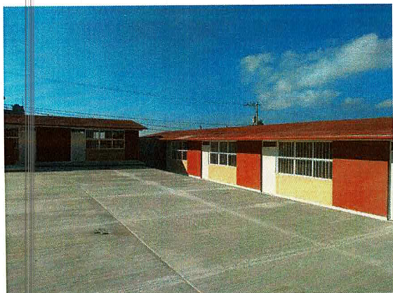
Construcción de 12 aulas, servicios sanitarios, dirección, cooperativa, bodega y obra exterior en la primaria lázaro cárdenas, ubicado en la localidad de ziráhuato, municipio de Zitácuaro, Michoacán.
