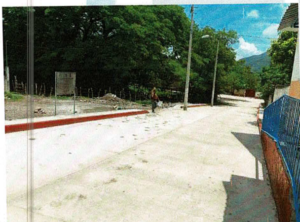
Pavimentación de calle la Parota, Melchor Ocampo, en el municipio de Nocupétaro de Morelos, Michoacán.
