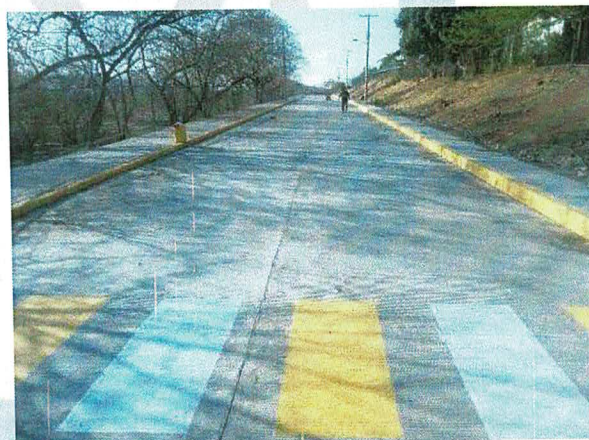
Construcción de pavimentación de la calle Aldama col. la arboleda, en el municipio de Tiquicheo, Michoacán.
