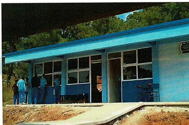
Construcción de dos aulas de 2e.e. en estructura u1c y obra exterior en el colegio de bachilleres, ubicado en le localidad de La piedad, municipio de La piedad, Michoacán.
